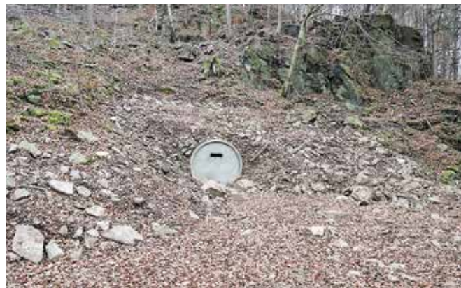
Das Mundloch des Stolln 2 am 1. Dezember 2020. Der freie Abfluss der Grubenwässer und der Zugang für Amphibien und Fledermäuse ist durch Öffnungen im Beton weiter gewährleistet. Mit großen Mengen an Beton ist die Standfestigkeit der verwahrten Grubenbaue gesichert. (Rechts vom Fotografen befindet sich die sogenannte „Kanzel“. Dazu aber mehr in der Reihe zum Burkhardtswald.)
