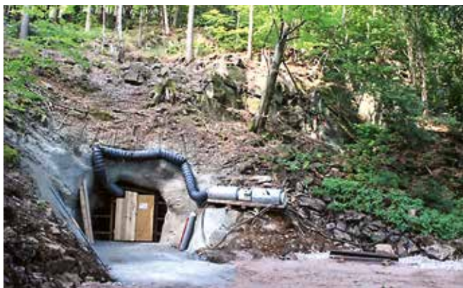
Das Mundloch während der Sanierungsarbeiten.
