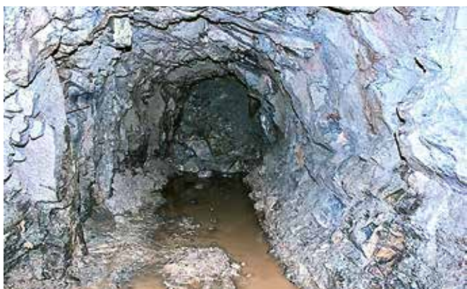
Der Stolln 2 ist in seinem Verlauf durch einen Verbruch auf der Hauptstrecke nicht weiter befahrbar gewesen.
